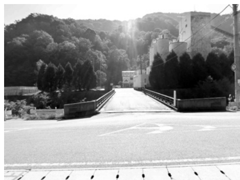
写真12 蓬莱峡新橋の全景(県道51号から渡ると会社入口)
