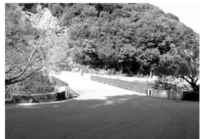
写真8 千都橋の全景 (橋の向こうは県道51号)
