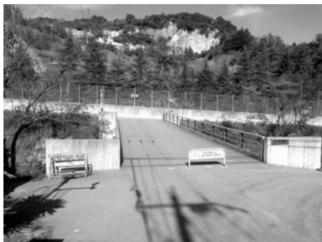
写真10 まさよし橋の全景
