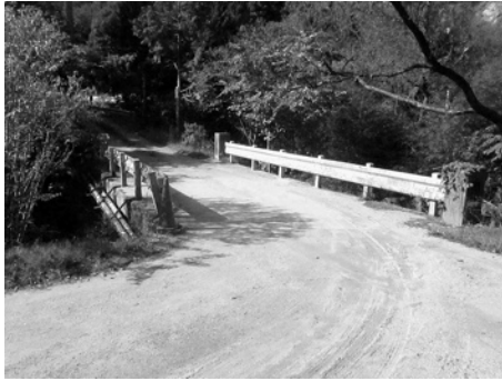
写真4 一雅橋の全景
