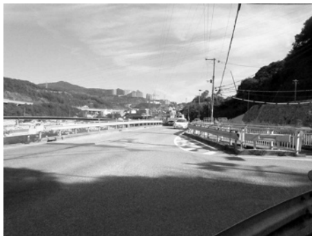
写真1 太多田橋（左が国道176号、手前右が船坂への県道51号）
