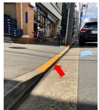
車道と歩道の段差5cmの例（矢印） ※ 前方に停車中の自動車を避けるために、歩道との段差5cmを乗り越えて走行する場合がある。
