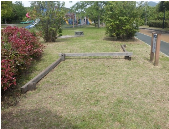
事故発生状況
