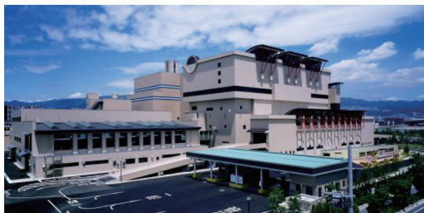
西部総合処理センター
