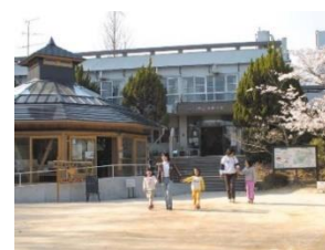
図 5-6 甲山自然環境センター
