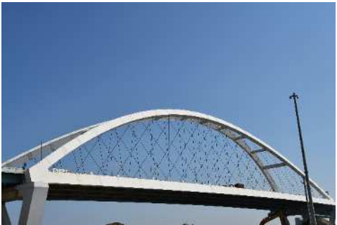
南側より見る西宮港大橋
