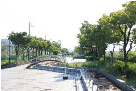
枝川四の橋交差点より南側を見る
