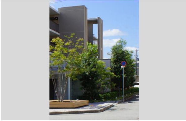
手前のエレベーターシャフト同様の意匠壁を、屋外階段の前面にも設け、すっきりとした印象におさめている。
