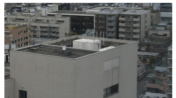
屋上設備の目隠しのために、建物の壁面と同じ意匠の壁を立ち上げ、建物全体の意匠性も損なわないよう配慮がなされている。
