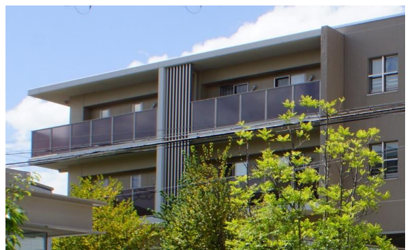
バルコニーにルーバーを設置し、ファサードデザインのアクセントにするとともに、配管等の目隠しとしてもうまく利用している。
