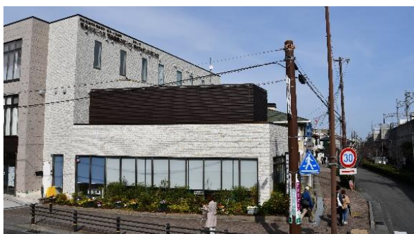
屋上設備の周りにルーバーを設置し、道路等から見えないよう配慮している。
