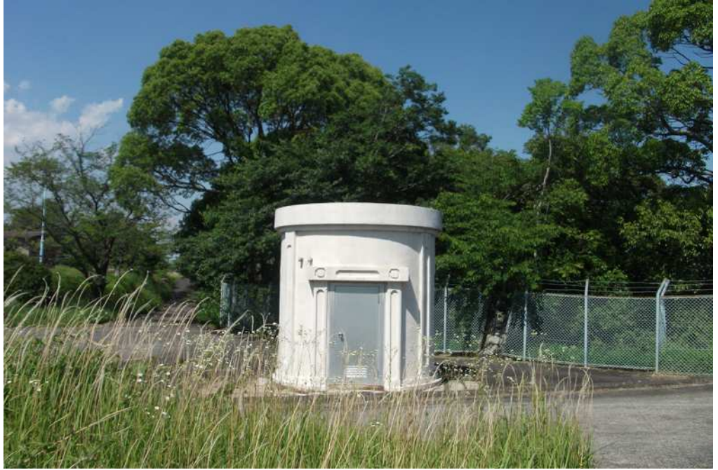
⑩ 緩速浄水井
