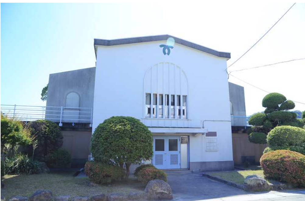
㉑ 急速ろ過棟 (近代化遺産)
