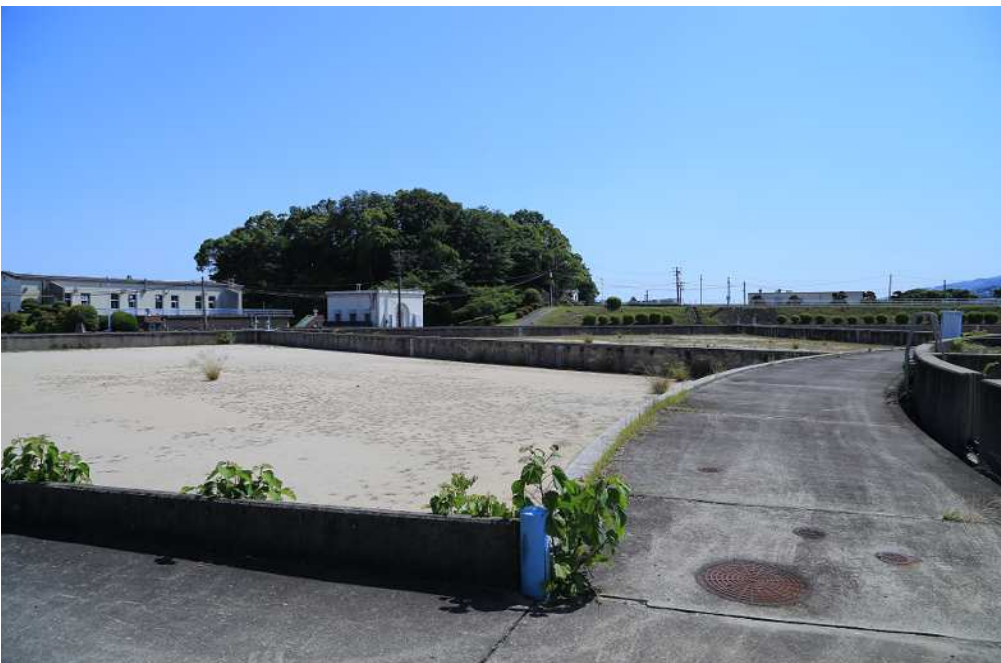
⑭ 緩速ろ過池 (近代化遺産)
