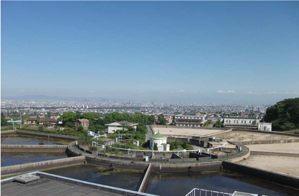
管理事務所から 緩速ろ過池を望む
