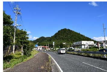
国道 176 号沿道（北六甲台付近）
