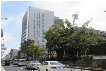
国道 2 号沿道（六湛寺町）
