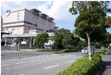
環境局環境施設部リサイクルプラザ (西宮市)
