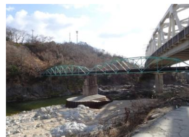
神戸市水道武庫川導水路橋脚
