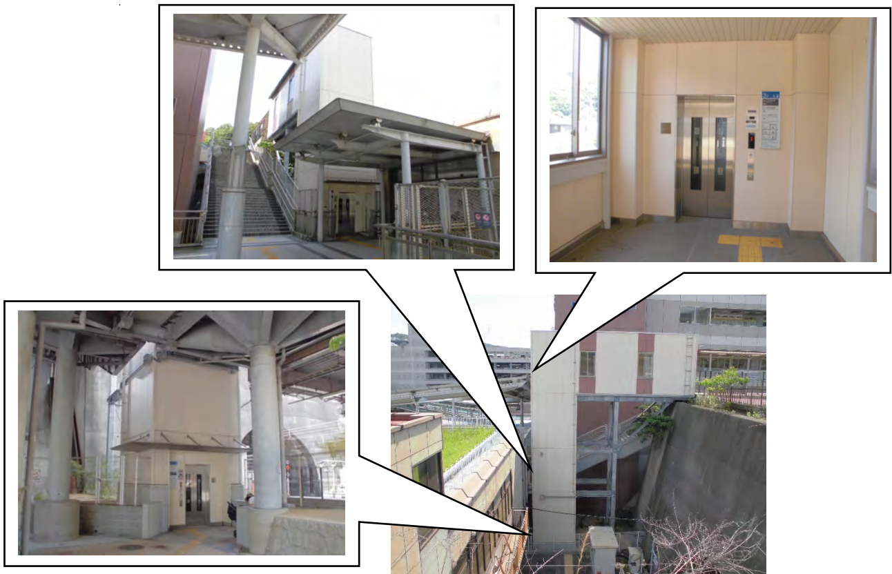
図Ⅲ-2-15 JR西宮名塩駅 エレベーター設置状況
