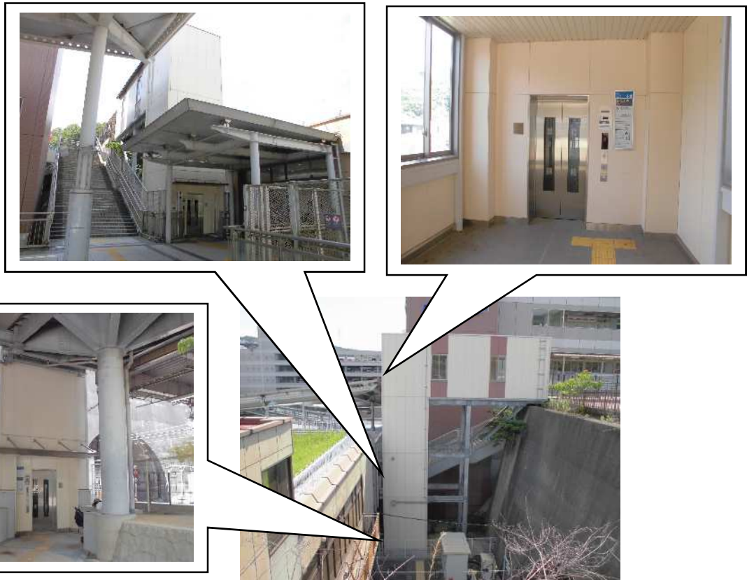
図Ⅲ-2-15 JR西宮名塩駅 エレベーター設置状況
