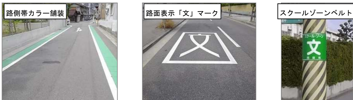
図Ⅲ-2-29 通学路の安全対策の実施例
