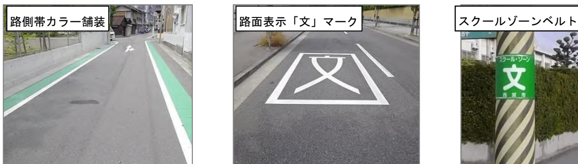
図Ⅲ-2-29 通学路の安全対策の実施例
