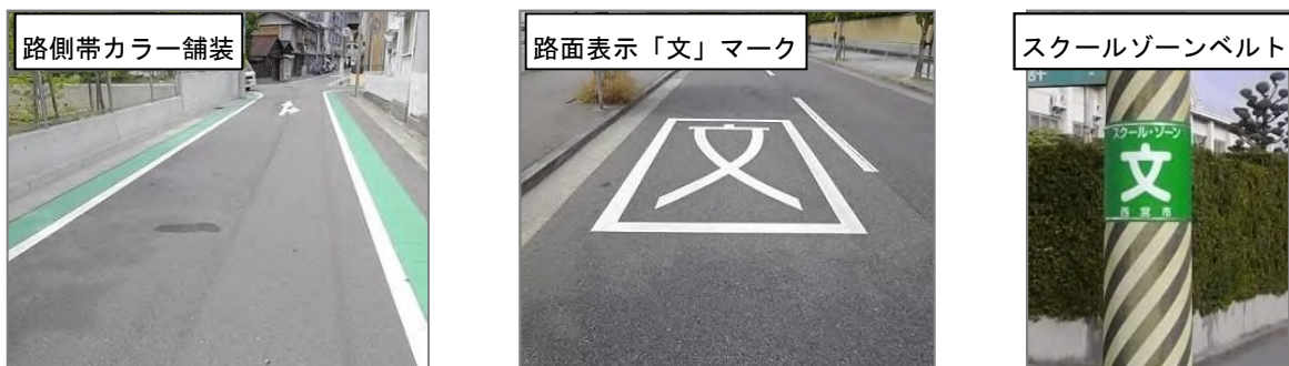
図Ⅲ-2-29 通学路の安全対策の実施例
