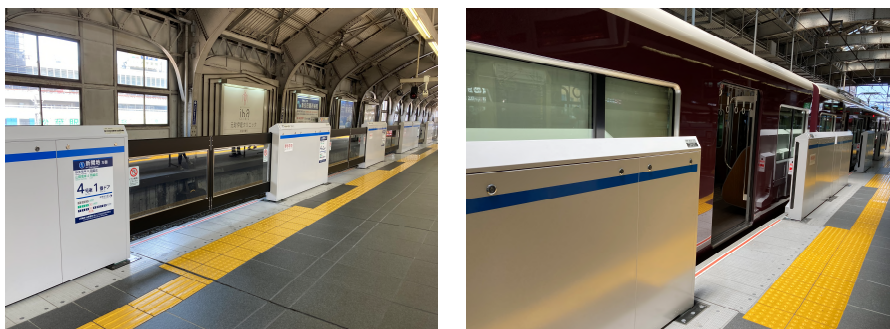
図Ⅲ-2-16 阪急電鉄神戸三宮駅 ホームドア設置状況
