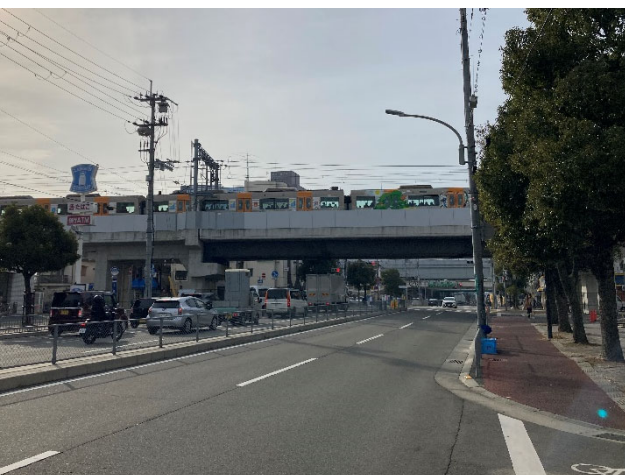
連続立体交差事業（阪神本線）
