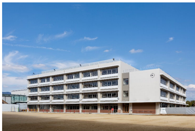
校舎の建替え（春風小学校）
