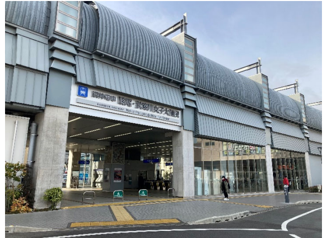
連続立体交差事業（阪神本線）
