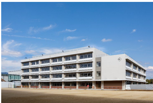
校舎の建替え（春風小学校）
