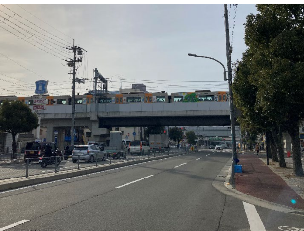
連続立体交差事業（阪神本線）
