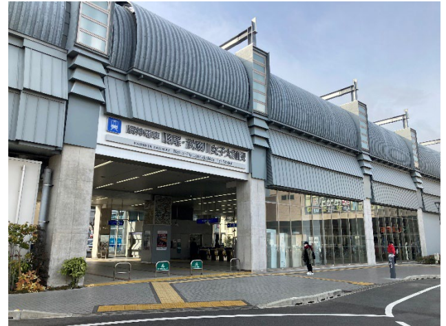
連続立体交差事業（阪神本線）
