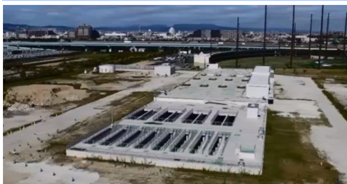
高度処理施設の整備（甲子園浜浄化センター）
