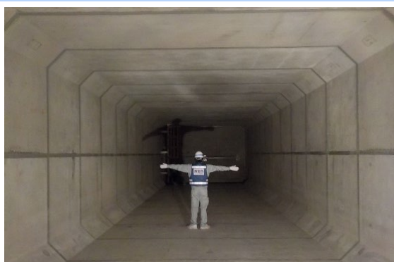
雨水貯留施設の整備（鳴尾駅前雨水調整地）
