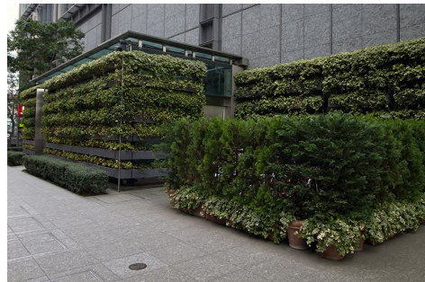
壁面緑化事例（東京都千代田区）
