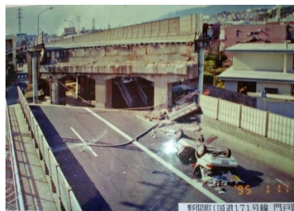
崩落した門戸陸橋
