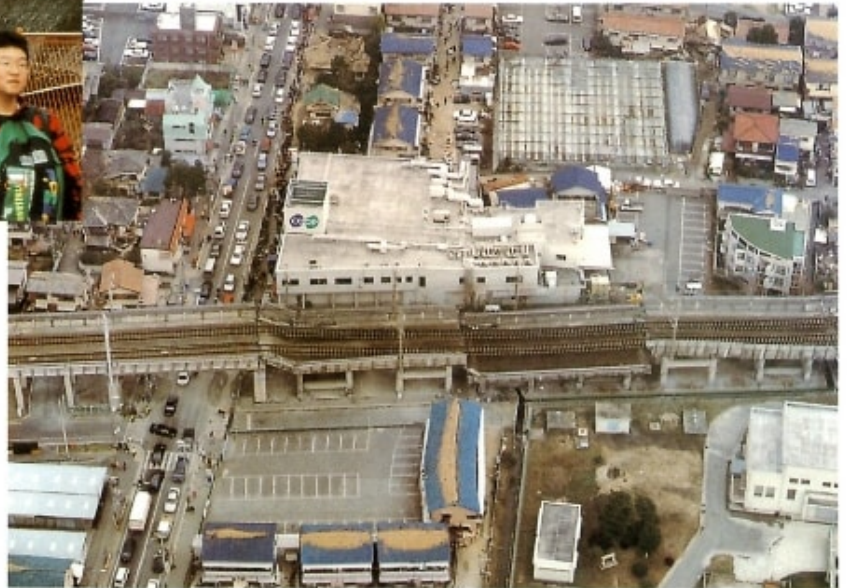
▲ 山陽新幹線高架橋が市内7カ所で落橋（上田市）
