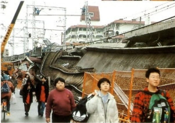
▲ 倒壊した阪急電車の線路沿いを歩く人々。 (若松町)
