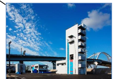
西宮市消防訓練施設
