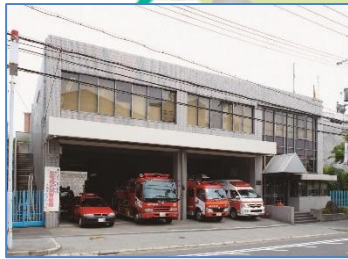
西宮消防署北夙川分署
