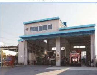
消防局整備センター
