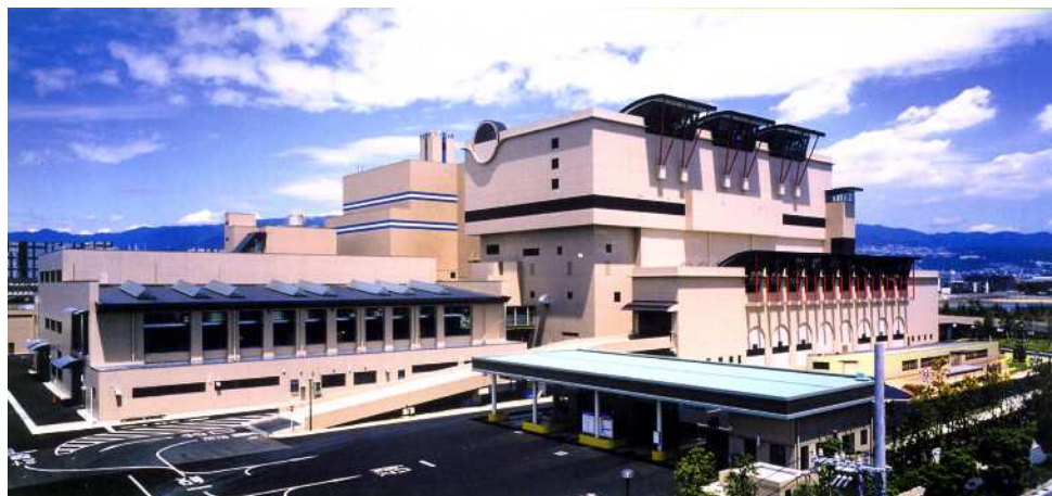
西部総合処理センター(焼却施設・破碎選別施設・リサイクルプラザ)
