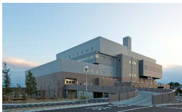
東部総合処理センター(焼却施設)
