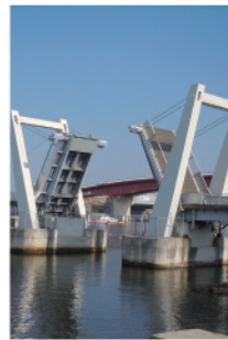
御前浜橋開閉の様子
