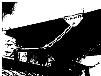
耐震補強のための緩衝チェーン(ショーボンド建設提供)
