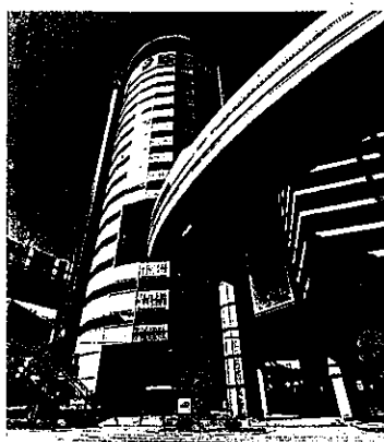
■立体道路制度を活用して整備された高速道路 =大阪市内
