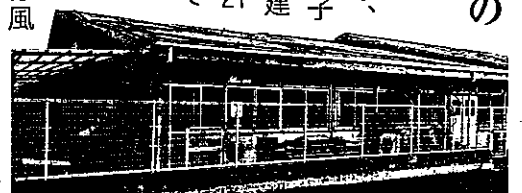
■台風21号で損傷した市立浜甲子園保育所の園舎=9月11日、枝川町
