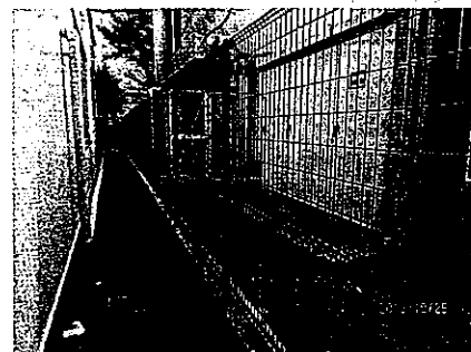
地震で危険個所とされたブロック塀を撤去後のフェンス
