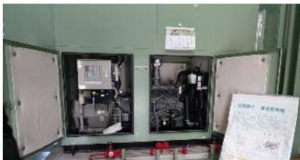
視察に行った宮排水機場の設備としては、排水ポンプ、原動機（排水ポンプの駆動設備）、自家発電機（停電時に施設内の設備に電気の供給をし、稼働させる）、給気消音機（稼働時の騒音抑制をする）、除塵設備〈1次スクリーン〉（上流から流れてくる粗大異物の進入を防止する）、除塵設備〈除塵機〉（1次スクリーンを通過し、ポンプの運転に支障をきたす異物の除去をする）、天井クレーン（機器の点検等の維持管理の運搬
