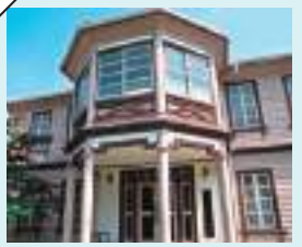
令和3年1月、今津の「六角堂」が県の景観形成重要建造物に指定
