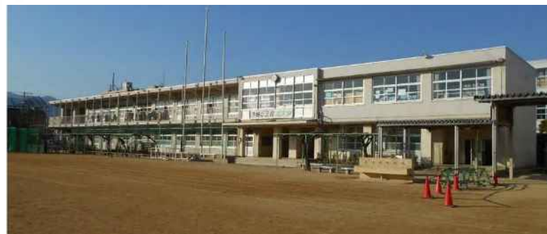
瓦木中学校現況
