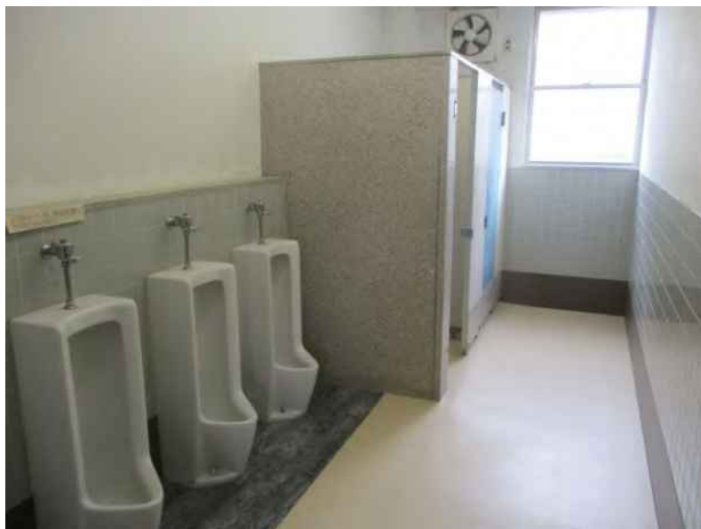
改修後のトイレ
