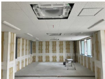
卸売北棟 2階事務所
