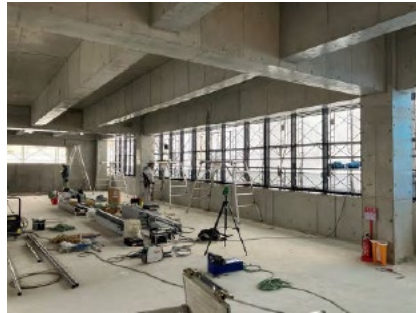
小売棟 2階事務所
