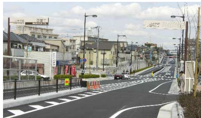
山手幹線大谷工区 (H20.3.29開通)
