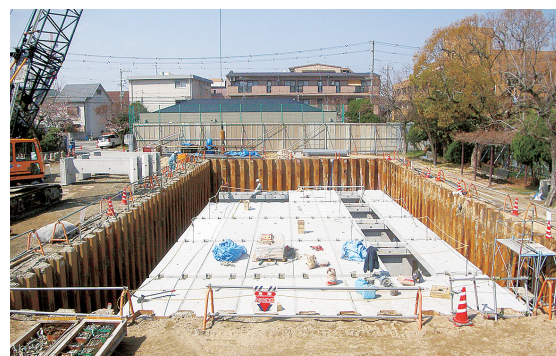
二見公園雨水調整池(地上)
