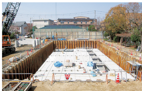
二見公園雨水調整池(地上)
